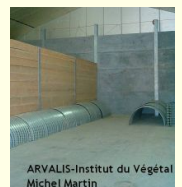
Stockage ventilé en vrac
